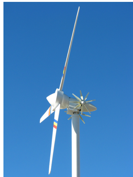
Figura 4. Turbină eoliană cu rotor basculant și orientare la direcția vântului prin roți-windrose instalată în parcul UTM [5].
